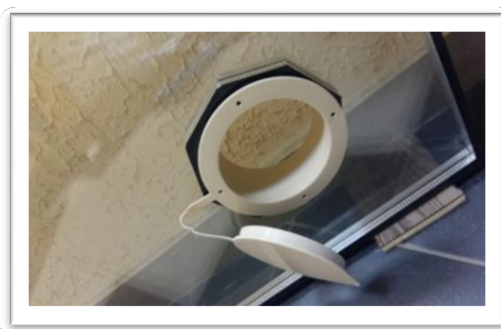
Рис. 4. Стеклопакет с технологическим окном для рекуператора
